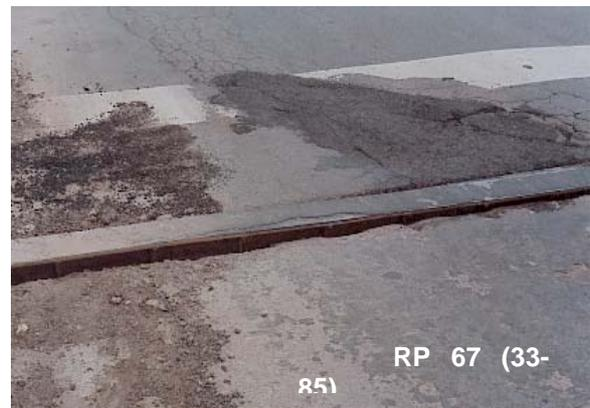
La falta o falla de juntas de dilatación puede observarse desde abajo del tablero viendo las manchas producidas por las filtraciones. Deben controlarse tanto las juntas construidas como tales, como las juntas de construcción (hormigonado en varias etapas, ensanches de tablero, etc.).
